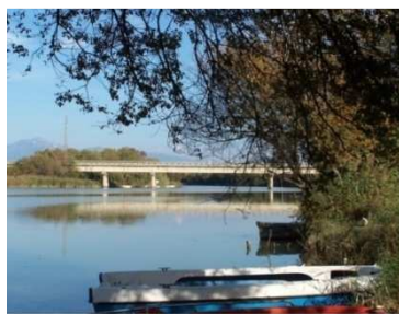
Ponte alla foce del fiume Sele
