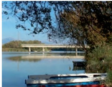
Ponte alla foce del fiume Sele
