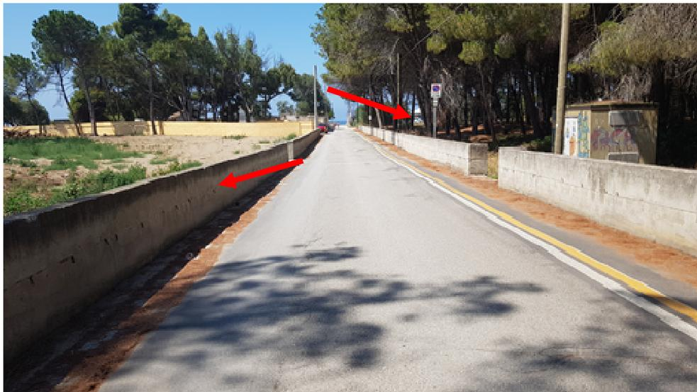
*Foto n. 2 – demolizione muretti esistenti, taglio alberi e pareggiamento*
