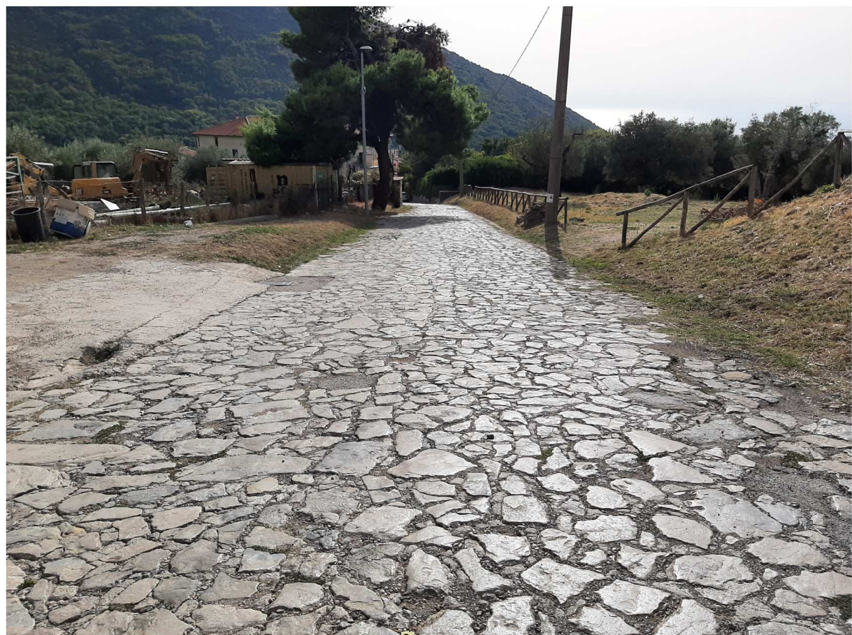
Foto 1 Stato di fatto del Tratto "N-O", con particolare della pavimentazione in pietra
