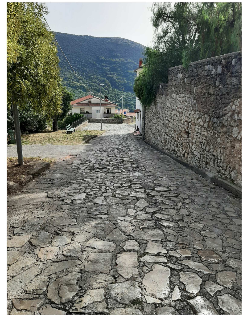
Foto 1 Stato di fatto del Tratto "O-P", con particolare della pavimentazione in pietra Rif. Sezione A-A1
