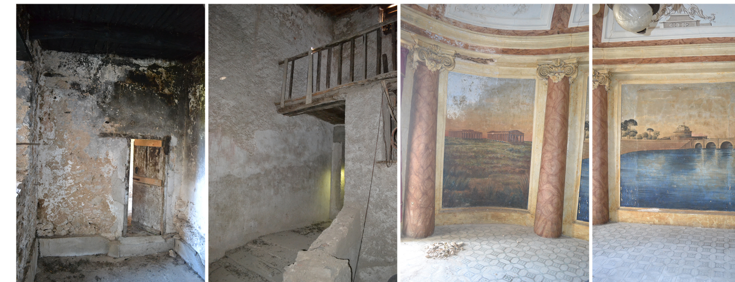
[1] efflorescenza crosta [2] efflorescenza macchie [3] lacuna alterazione cromatica [4] alterazione cromatica macchie
