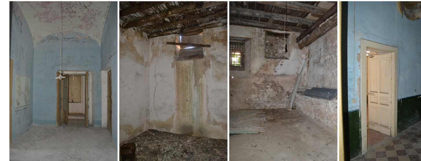
[5] alterazione cromatica macchie [6] patina biologica macchie da dilavamento [7] distacco dell'intonaco macchie [8] distacco dell'intonaco impianti a vista
