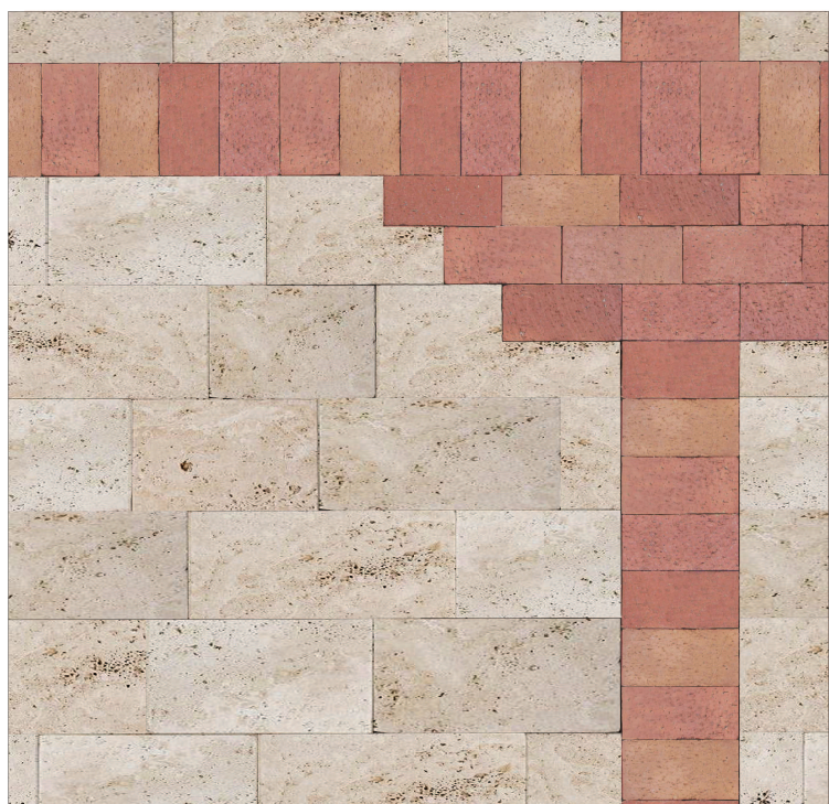
Pavimentazione della piazza in lastre di travertino a correre e fasce in mattoni di argilla
