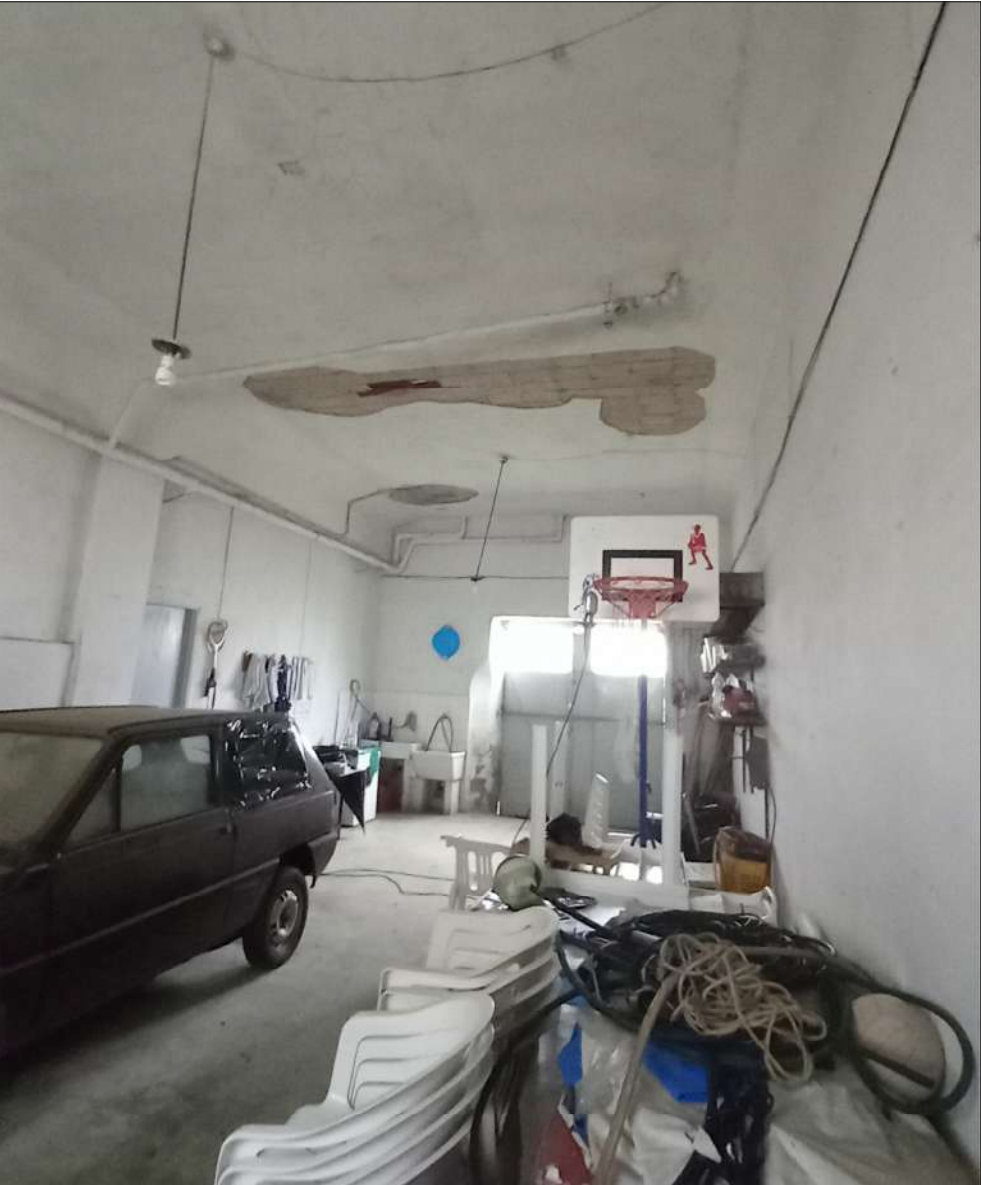
FOTO 5 Amiente deposito Piano terra. Dettagli del solaio in latero cemento e pavimentazione in graniglia semplice in cattivo stato
