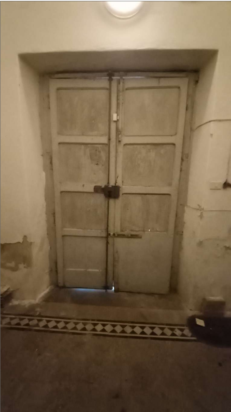
FOTO 3 Ingresso principale lato nord. Dettaglio pavimenzione originale in graniglia da recuperare presente nell'intero corpo scala
