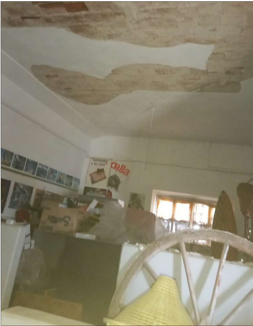
FOTO 6 Ambiente deposito Piano terra. Dettagli del solaio in latero cemento e pavimentazione in battuto
