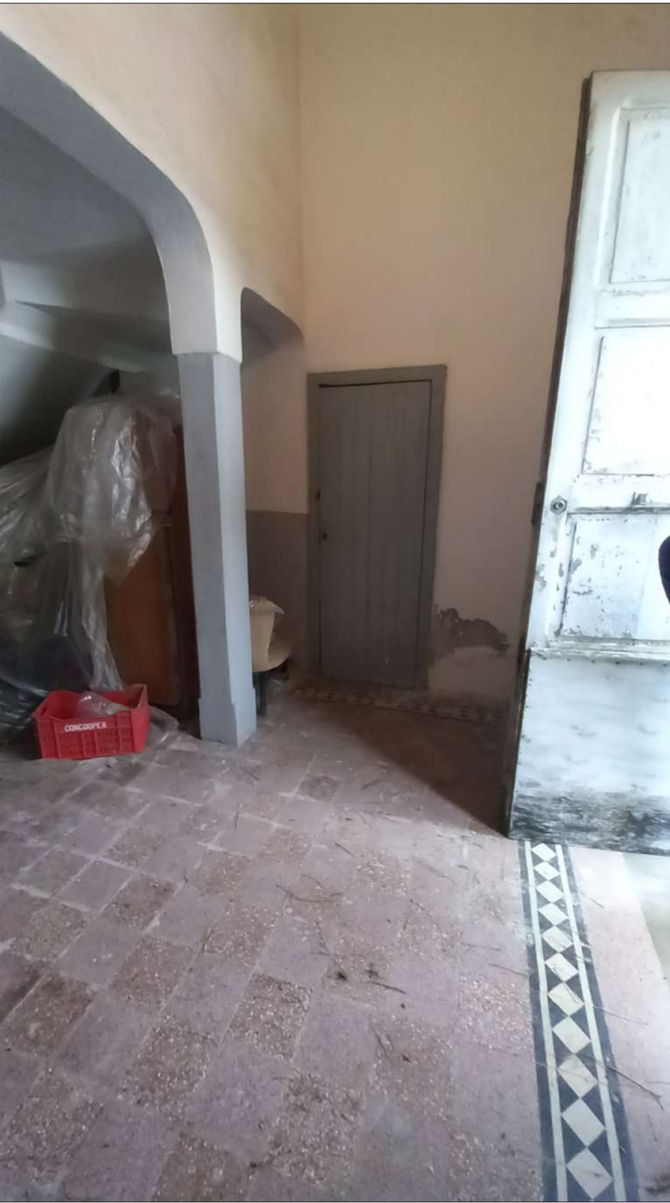
FOTO 2 Ingresso principale lato nord. Dettaglio pavimenzione originale in graniglia da recuperare presente nell'intero corpo scala
