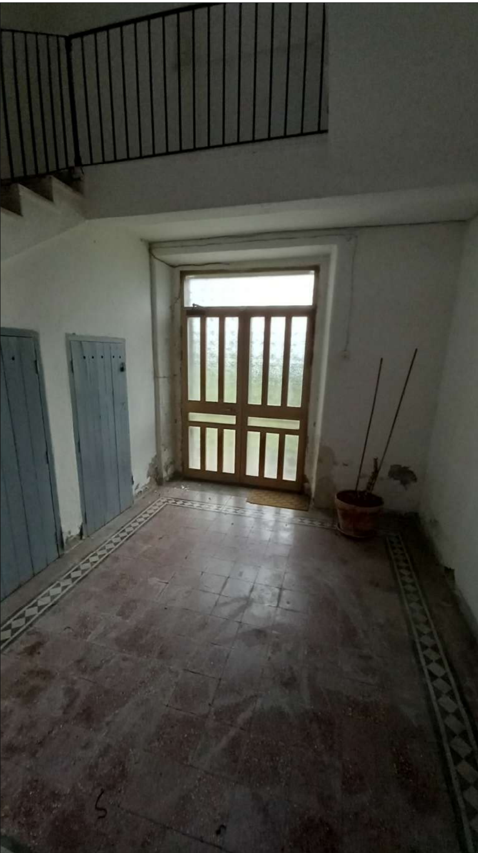
FOTO 8 Ingresso principale lato SUD. Dettaglio pavimenzione originale in graniglia da recuperare presente nell'intero corpo scala
