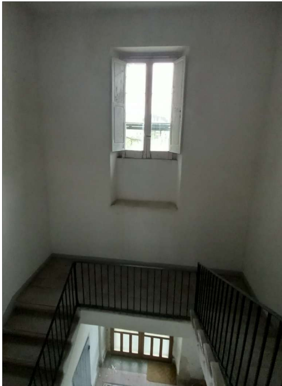
FOTO 2 Ingresso principale lato SUD. Dettaglio infisso interno in legno e solaio in latero cemento
